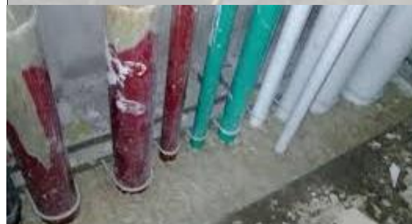
Penggunaan firestop pada shaft untuk mencegah penyebaran api
